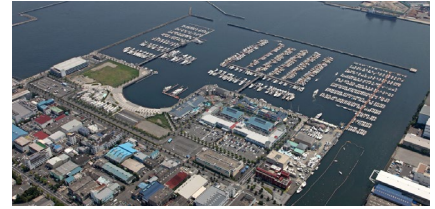
白帆地区 平成30年 (横浜ベイサイドマリーナ地区)
