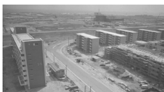
建設中の住居
